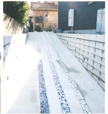
駐車場のコンクリートには波佐見焼のかけらを埋め込んだ。
