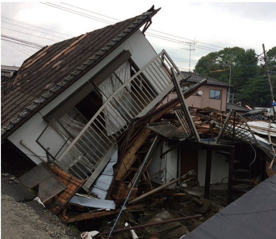
益城町の倒壊した建物。軟弱な地盤の影響が大きい。
