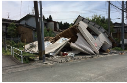
南阿蘇村では、このような比較的新しい家でも被害が多く見られた。
